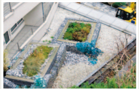
Grünelmente auf einem Dach, die auf einem Substrat mit Kompostanteilen angelegt wurden.
