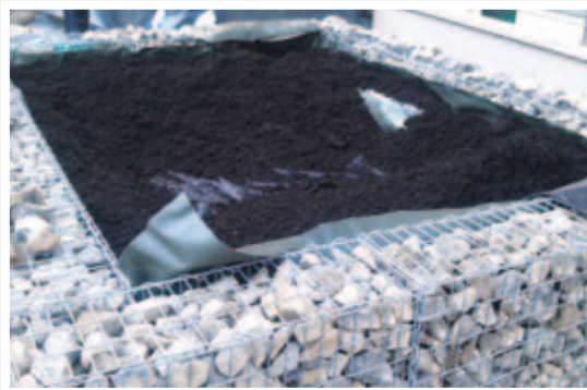
Vorbereitung einer Fläche zur Dachbegrünung mit Kompost.
